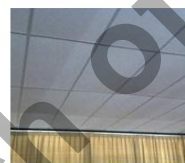
↑ Ceiling Grid & Ceiling Board Installation . Below : Light Boxes & Lightings installation ↑ 安装天花板网格 & 吊顶板 下图：安装灯箱 & 灯管
